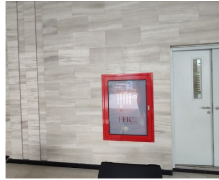
ผู้เก็บสายฉีดน้ำดับเพลิง และไฟฟ้าส่องสว่างฉุกเฉิน
