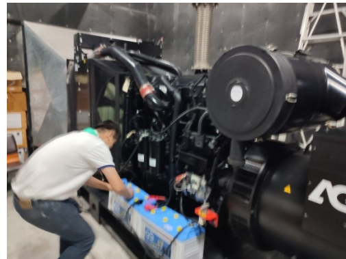
ภาพที่ 5-3 ห้องเครื่องไฟฟ้าสำรอง ดูแลตรวจสอบ และทดสอบให้อยู่ในสภาวะพร้อมใช้งาน
