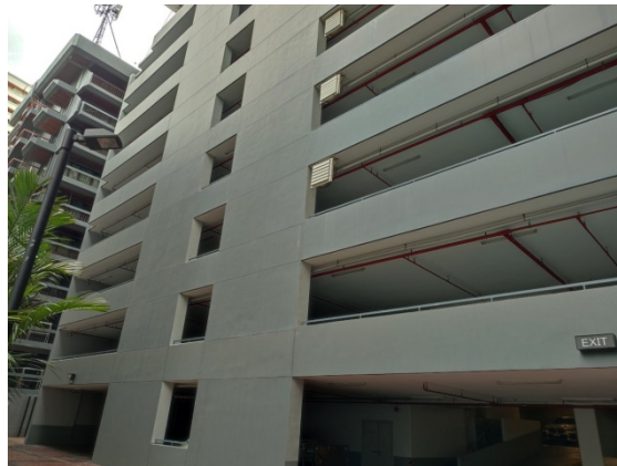
ภาพที่ 5-51 ปรับปรุงผนังอาคารจอดรถด้านทิศใต้ของอาคาร เป็นผนังกันเสียง ปิดทับป้องกันผลกระทบด้านเสียงจากอาคารจอดรถ ไปยังอาคาร ฟิเอส เจ อพาร์ทเมนต์ และอาคาร โรงแรม คราวน์ บีทีเอส นานา
