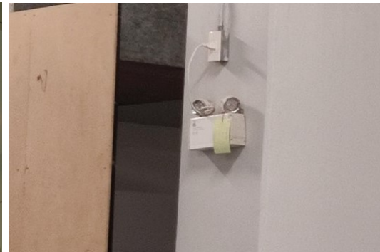
ระบบป้องกันอัคคีภัยและเตือนภัย ภายในห้องพักอาศัยและไฟฟ้าส่องสว่างฉุกเฉิน
